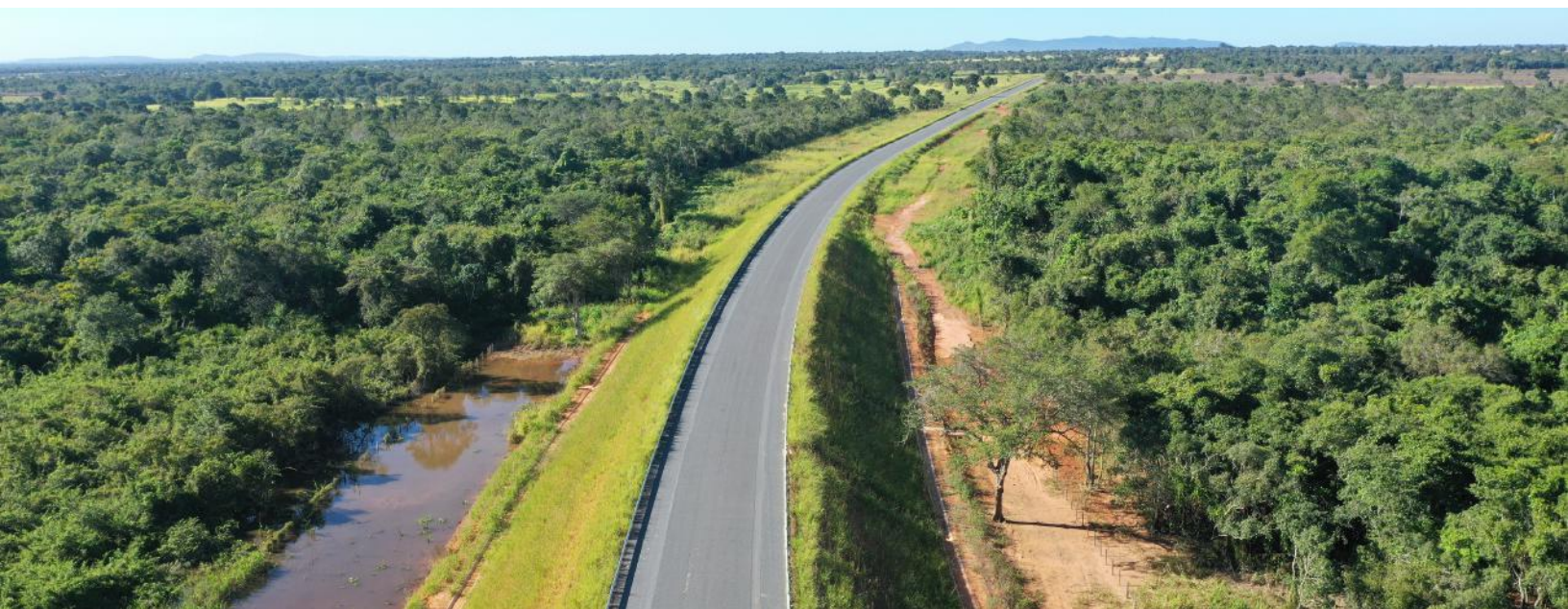
Etapas finais da implantação da BR-080: ligação de Brasília ao Mato Grosso
