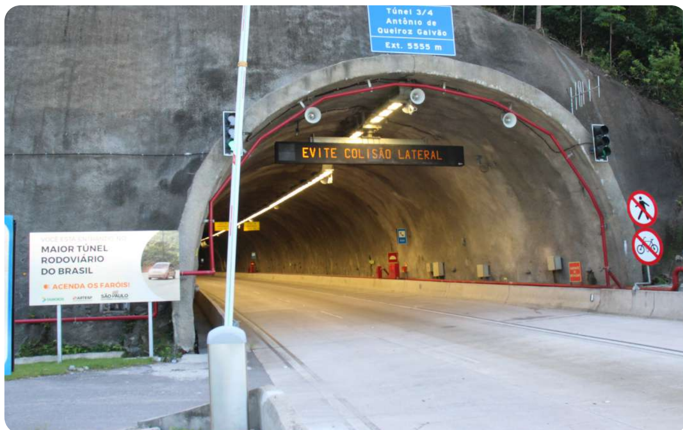
Rodovia dos Tamoios, em São Paulo, obra realizada pela Álya Construtora
