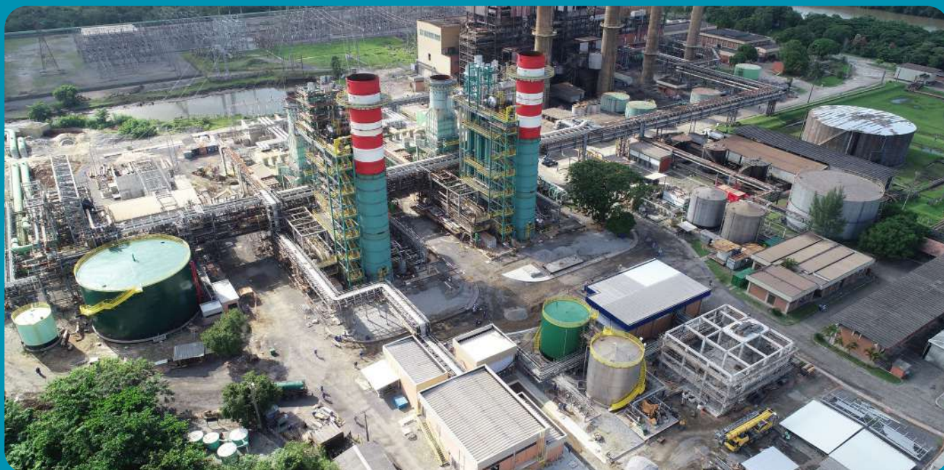
Antes da modernização, a UTE Santa Cruz contava com capacidade instalada de 350 MW
